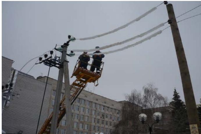
Рис. 3. Закрепление заготовок льда цилиндрической формы на фазных проводах модели ВЛ
