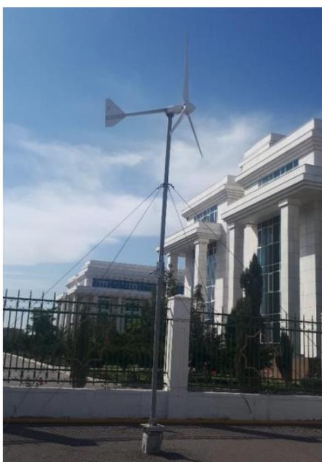
Рис.5. Ветроэлектростанция мощностью 2 кВт установленная на территории ГЭИТ
