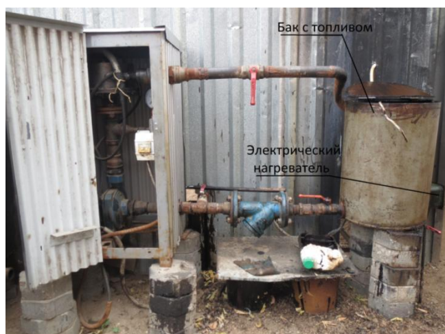
Рис.6. Бак с топливом и электрическим нагревателем Fig.6. Fuel tank with electric heater
