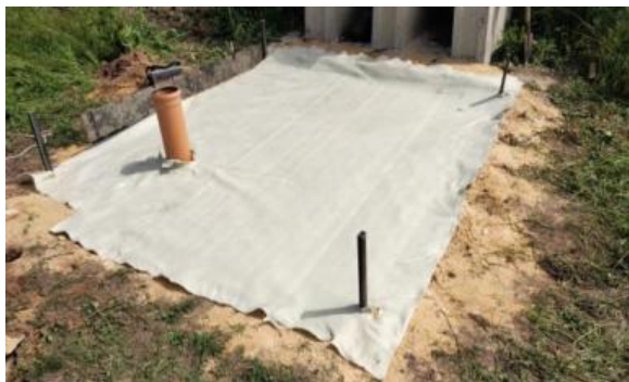
Рис. 6 Фото укладки геотекстиля
