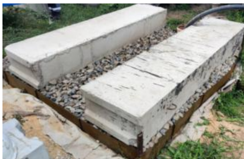
Рис. 8 Установка фундаментных блоков для КТП
