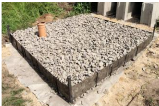
Рис. 7 Фото монтажа каркаса фундамента КТП
