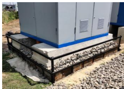
Рис. 10 Фото смонтированной рамы
