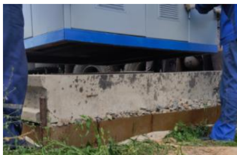
Рис. 9 Установка корпуса КТП
