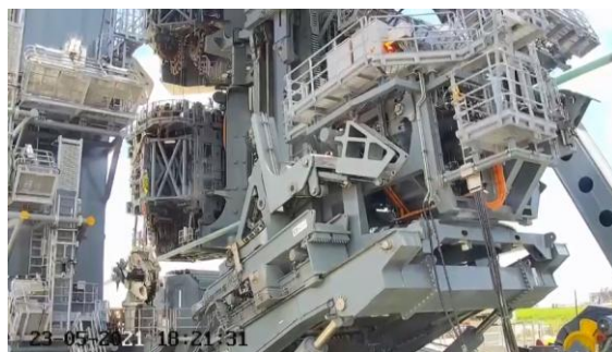
Рис.4. Натяжитель (тензионер) после аварии
