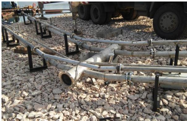
Рис 1. РЗУ типа «водовоздушная завеса» перед установкой в Заинском Водохранилище
