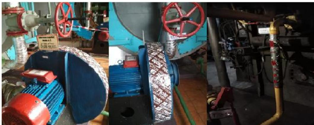
Рис. 9. Установка XPLate пластин на вентилятор водогрейного котла КВГМ-4 и на газовой трубопровод перед газовой горелкой
