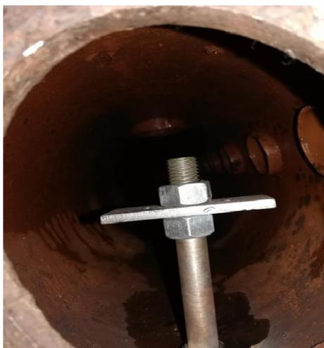
Рис. 4. Внешний вид тест-пластины, установленной в коллекторе котла
