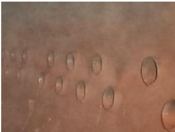
Рис. 5. Состояние стенок теплообменника котла с установленным опытно-промышленным антинакипным устройством
