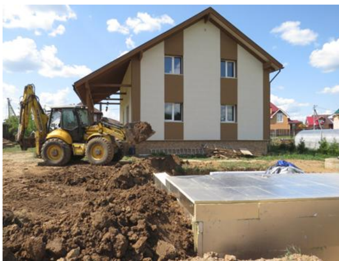
Рис. 2. Процесс монтажа сезонного подземного ТА Fig. 2. Installation process of a TES device
