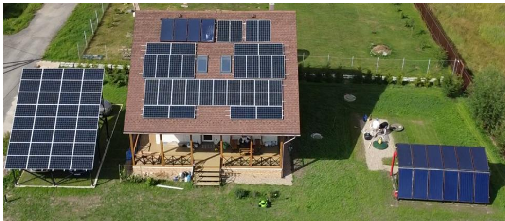
Рис. 8. Сезонный подземный тепловой аккумулятор с солнечными коллекторами (справа), солнечными панелями на навесе для электромобилей (слева) и на крыше (в центре)
