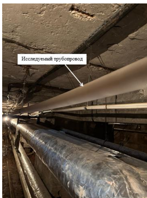
Рис. 8. Фотография полипропиленового трубопровода Fig. 8. Photograph of a polypropylene pipeline *Источник: Составлено авторами Source: compiled by the author.
