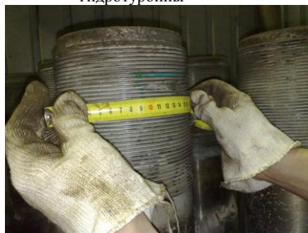
в) выкрашивание резьбы на крепежных элементах ПЛ гидротурбины
