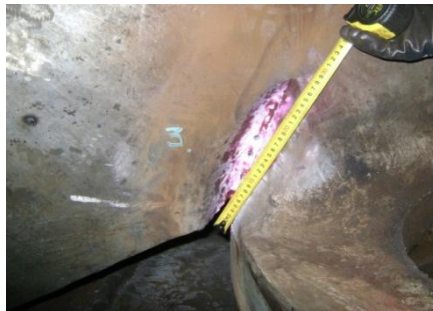
а) трещина в зоне перехода пера во фланец лопасти поворотной лопасти гидротурбины
