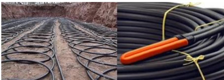
Рис. 3. Классические виды коллекторов теплового насоса. Горизонтальный коллектор и вертикальный зонд
