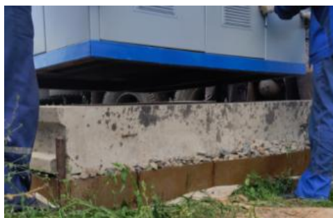
Рис. 9 Установка корпуса КТП
