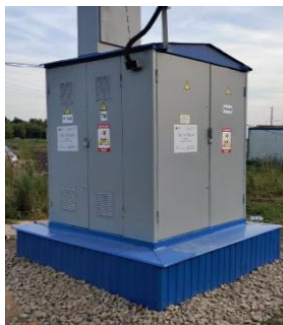
Рис. 12 Фото усовершенствованной «подушки» фундамента КТП киоскового типа
