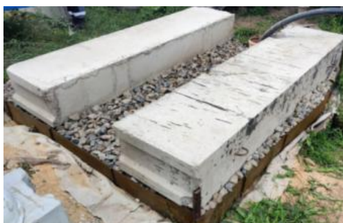
Рис. 8 Установка фундаментных блоков для КТП
