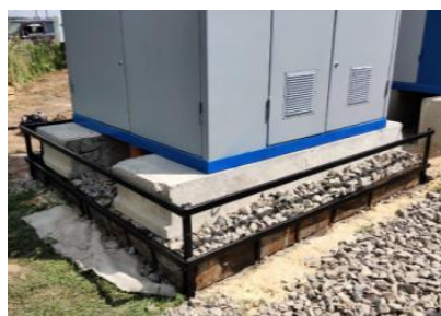
Рис. 10 Фото смонтированной рамы
