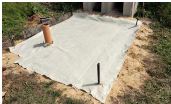
Рис. 6 Фото укладки геотекстиля
