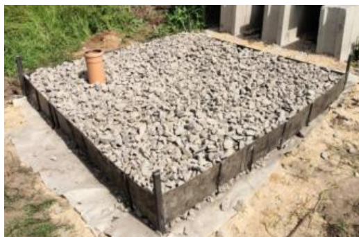
Рис. 7 Фото монтажа каркаса фундамента КТП
