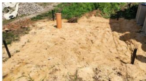
Рис. 5 Утрамбованная песчаная подушка
