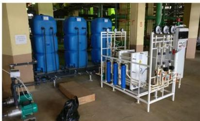
Рис. 4. Устройство и состав оборудования электромембранной установки переработки высокоминерализованных отходов ионитной водоподготовительной установки Нижнекамской ТЭЦ-1.
