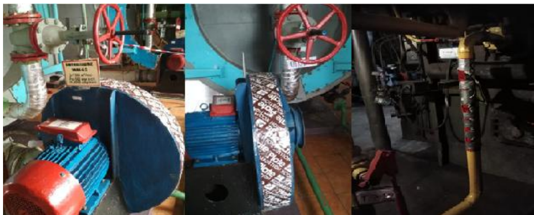
Рис. 9. Установка XPLate пластин на вентилятор водогрейного котла КВГМ-4 и на газовый трубопровод перед газовой горелкой
