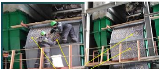
Рис. 8. Установка XPLate пластин на воздушный вентилятор работающего котла ТГМЕ-464
