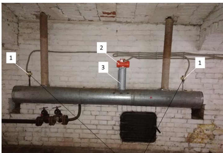
Рис. 3. Схема монтажа опытно-промышленного антинакипного устройства на котле ДЕ-25-24:
