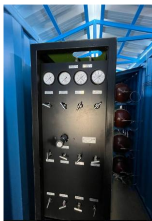
Рис. 11. Газовая рампа для водорода для ВЗС контейнерного типа (полигон КГЭУ)
