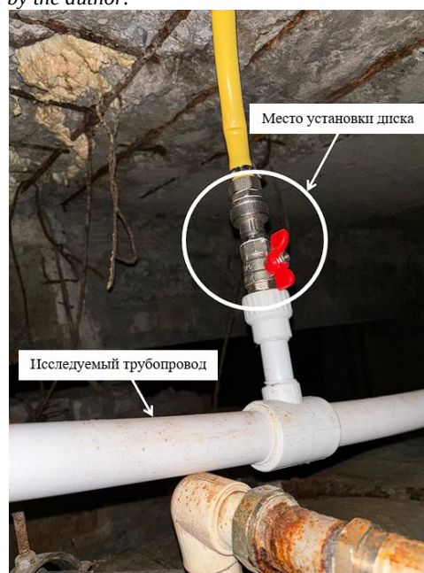
Рис. 9. Фотография места установки диска на полипропиленовом трубопроводе
